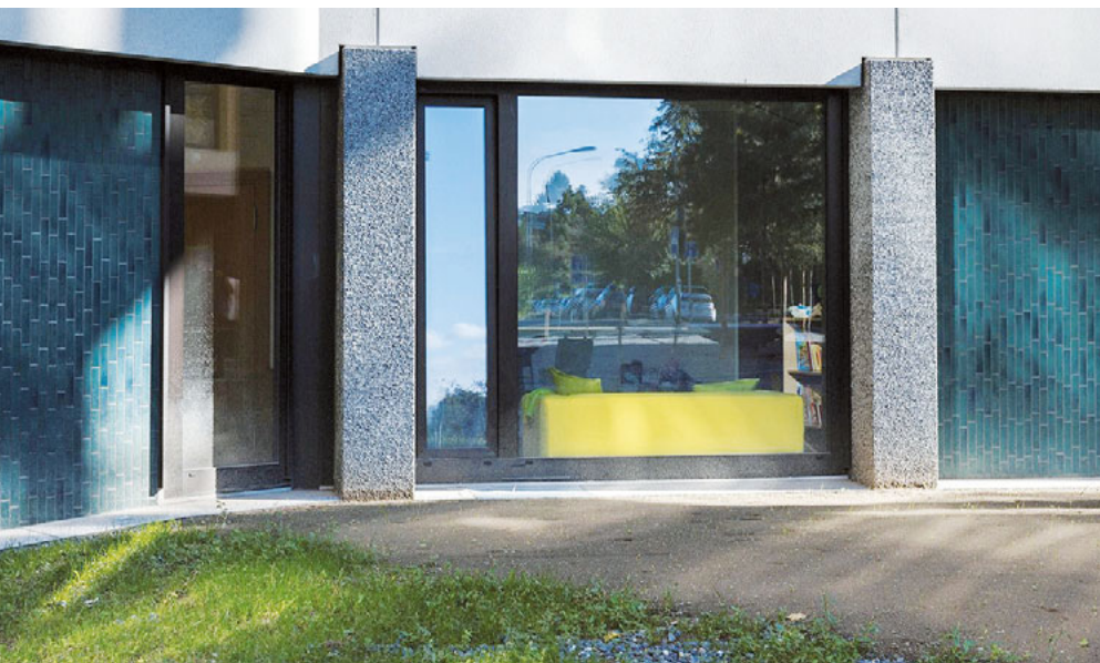
Die Siedlungsgenossenschaft Eigengrund als Bauherrin legte viel Wert auf nachhaltige Baumaterialien, zum Beispiel bei der sorgfältigen Gestaltung der Fassade.
