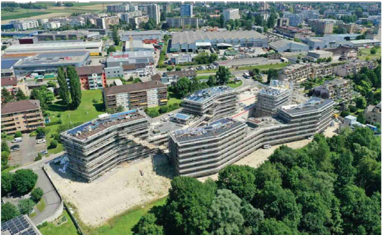
Une vue aérienne de l'écoquartier Codha en construction à la rue du Stand, à Nyon (état au 20 juillet 2021). MICHEL PERRET
