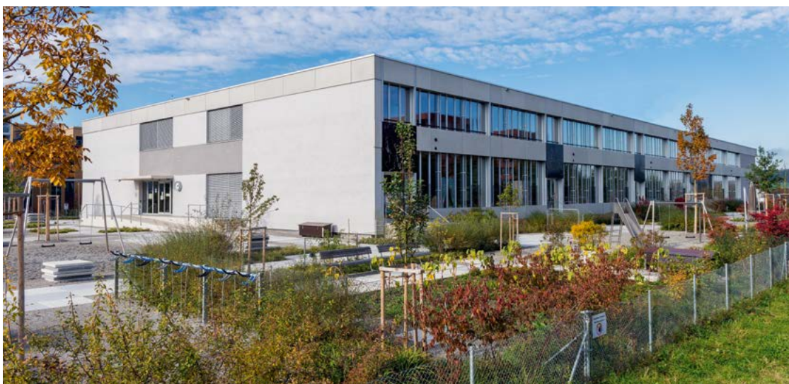
Schulanlage Blumenfeld Zürich, Minergie-P-ECO
