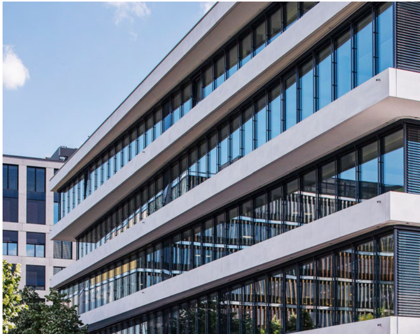
Erster Träger des SNBS-Gebäudezertifikats: der neue Geschäftssitz von Losinger Marazzi an der Wankdorfallée in Bern.
